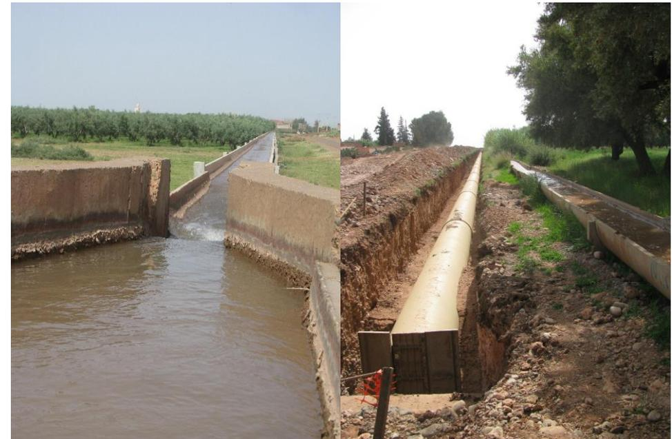
Canal d'amenée de l'eau en gravitaire (gauche) et modernisation du réseau d'amenée (droite) avec la création d'un système de canalisations sous pression enterrées. Périmètre du Tensift. Maroc.
